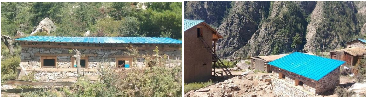
Duschbyggnaden och toaletten som de såg ut i augusti.
