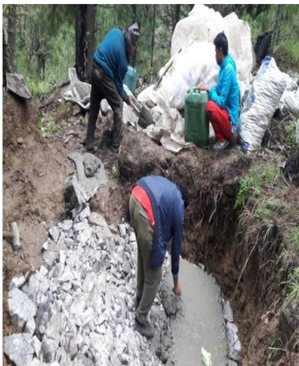
Arbete med den nya vattenledningen. Allt görs för hand.
