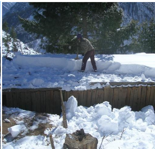
Snöskottning på taket till det provisoriska köket
