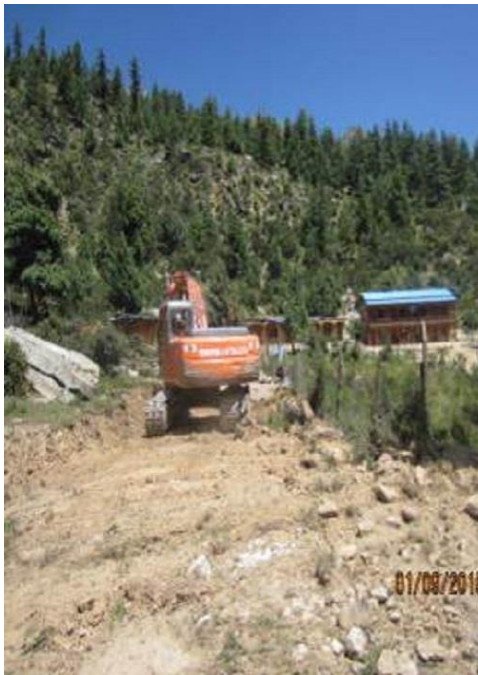
Väg byggs till skolhemmet.
